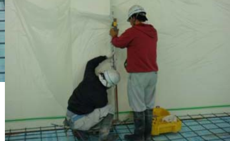
レベルポイントの確認
